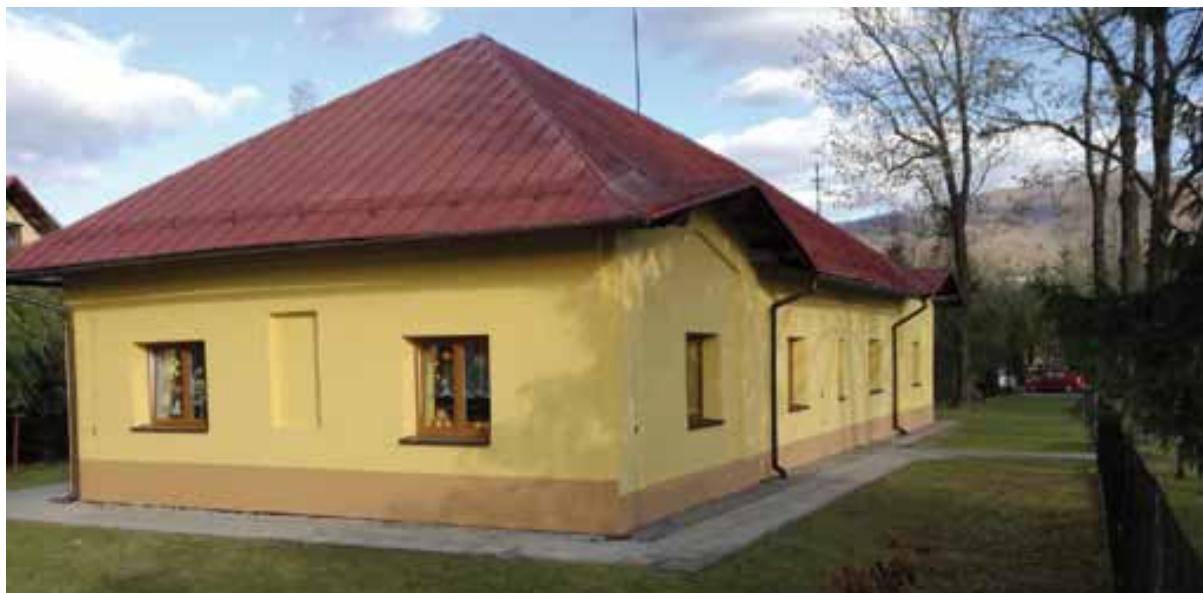
Termomodernizacja Przedszkola nr 2.
