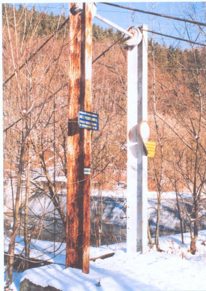
Fot. 3. Pylon prawy patrząc od strony dołu rzeki.
