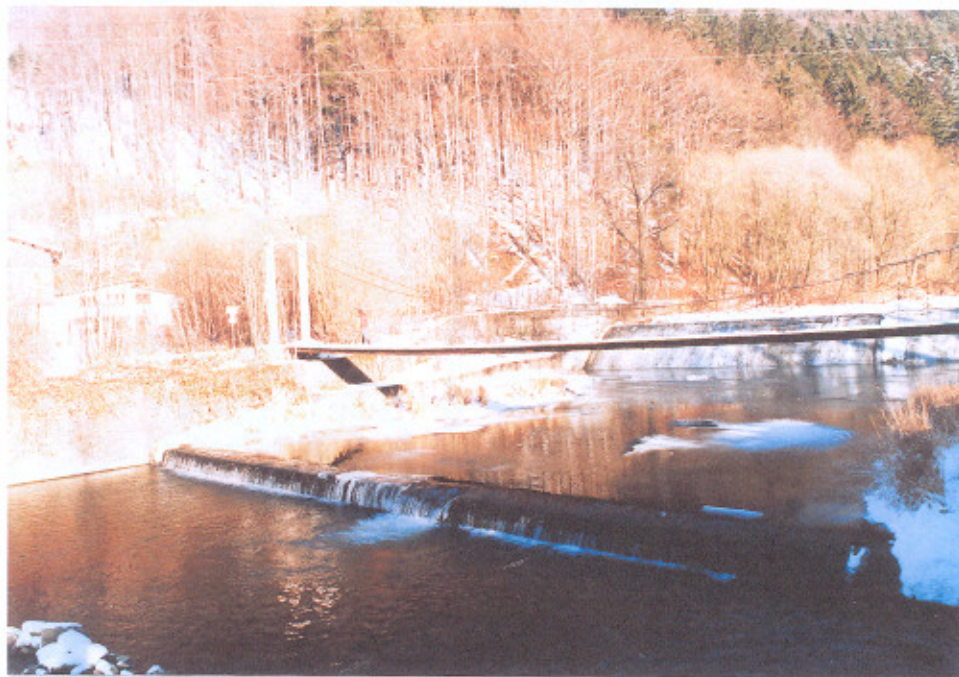
Fot. 1. Widok na obiekt od strony dołu rzeki.
