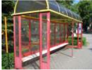
Ustroń Centrum przy Fundacji
