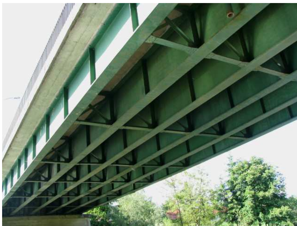
Fot. 4. Widok mostu od spodu
