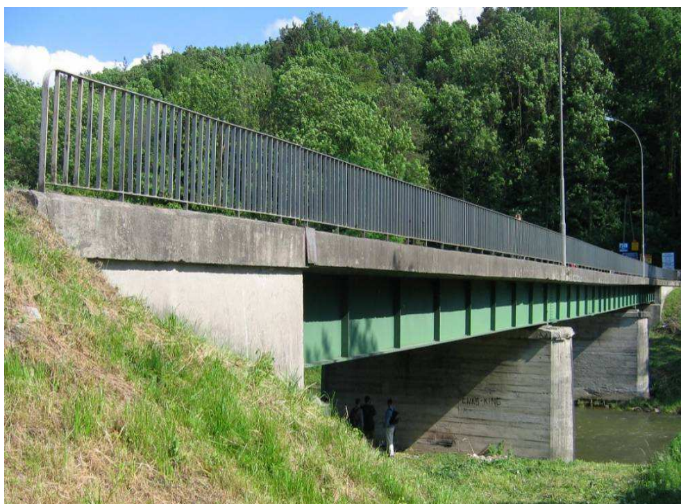
Fot. 2. Widok wzdłuż mostu, od strony góry rzeki. Na pierwszym planie przyczółek od strony Krakowa - podpora nr 1
