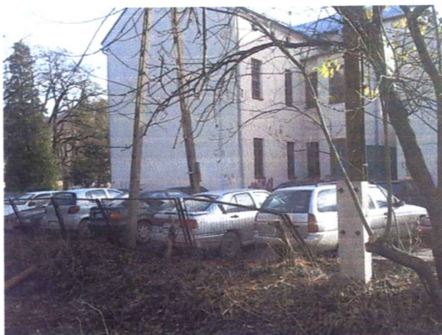
Zdj. 5 Widok na istniejący parking od strony ul. A. Brody.
