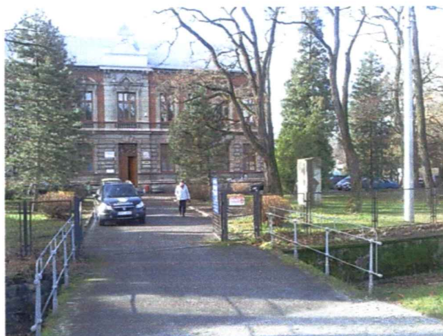
Zdj. 1 Widok na istniejący deptak, mostek oraz frontową elewację budynku.
