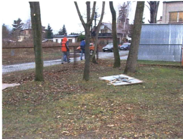
Zdj. 8 Drzewa od strony drogi - przeznaczone do wycinki.
