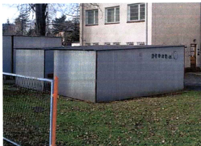
Zdj. 7 Blaszane garaże przeznaczone do rozbiórki
