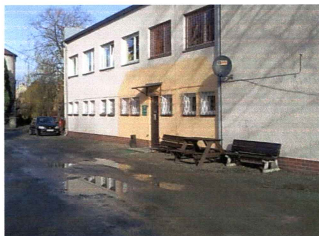
Zdj. 10 Elewacja tylna oraz istniejąca droga za budynkiem – projektuje się zmianę nawierzchni.
