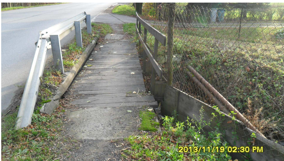
fot. 1 Istniejąca kładka dla pieszych w ciągu ul. Skoczowskiej nad potokiem Młynówka w Ustroniu, usytuowana stycznie do istniejącego mostu. Widoczne przewody teletechniczne od strony dolnej wody.
