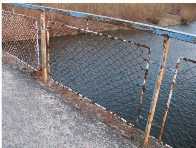
Fot. 3 Widok pojedynczego pola balustrady z siatki ogrodzeniowej w ramce z pręta \varnothing 12\text{mm} .
