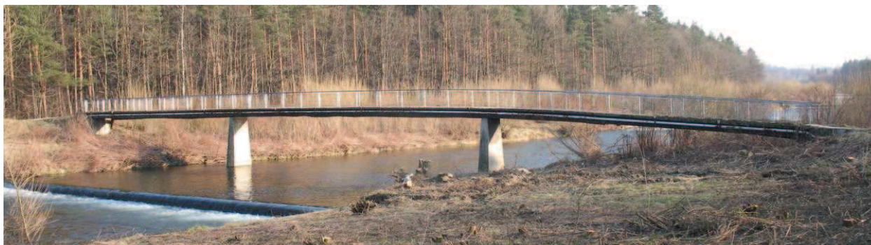
Fot.1 Widok kładki od strony dolnej wody
