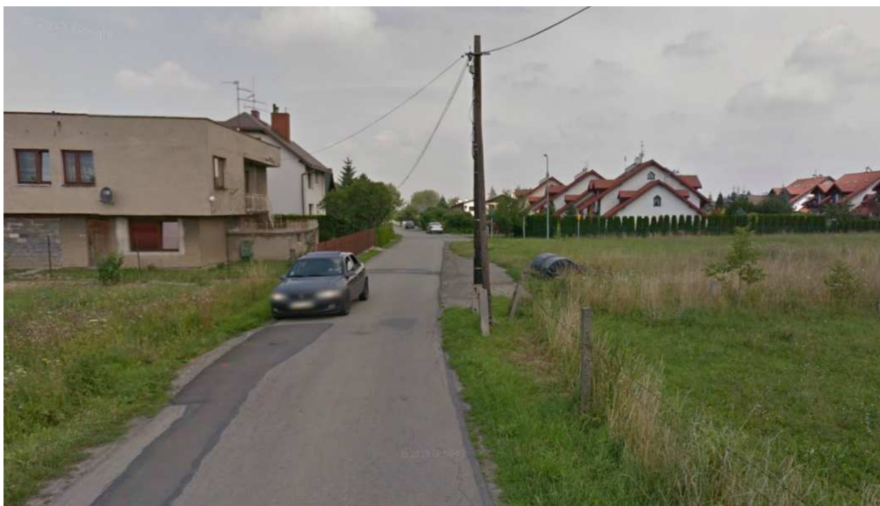
Fot.5 Słupy teletechniczne do przebudowy
