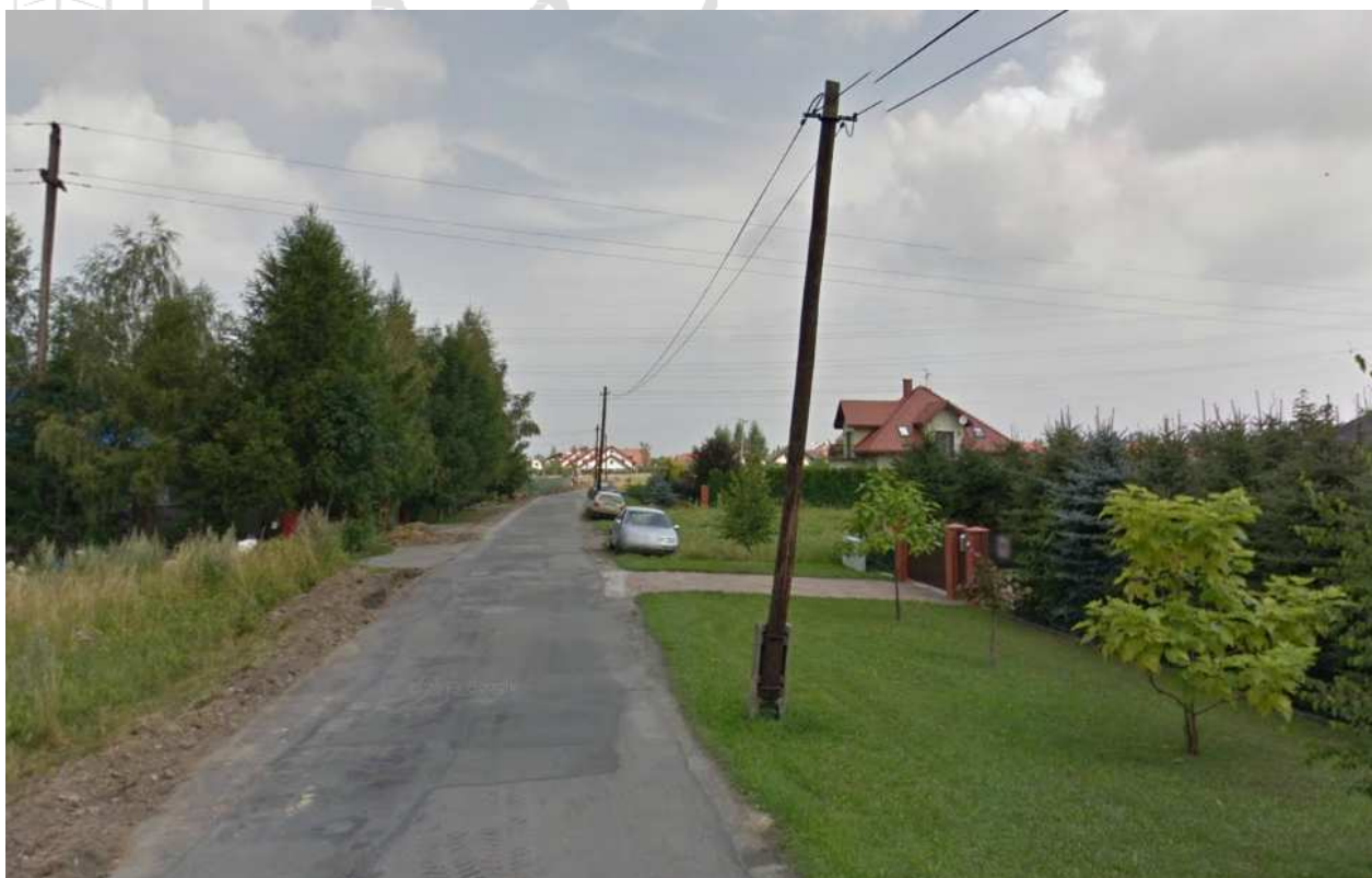
Fot.4 Słupy teletechniczne do przebudowy
