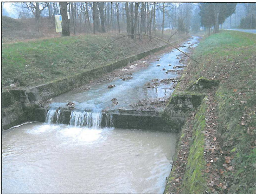
Fot. nr 1. Ogólny widok koryta potoku
