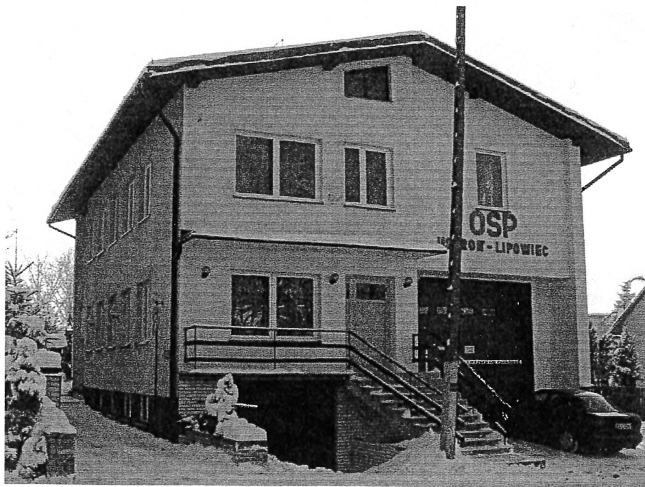
Fot. 1. Elewacja północna i wschodnia
