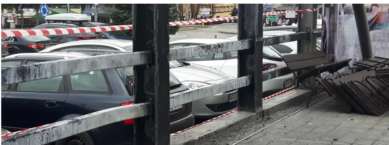
Fot. nr 3. Okopcone słupy i rygle palisady.
