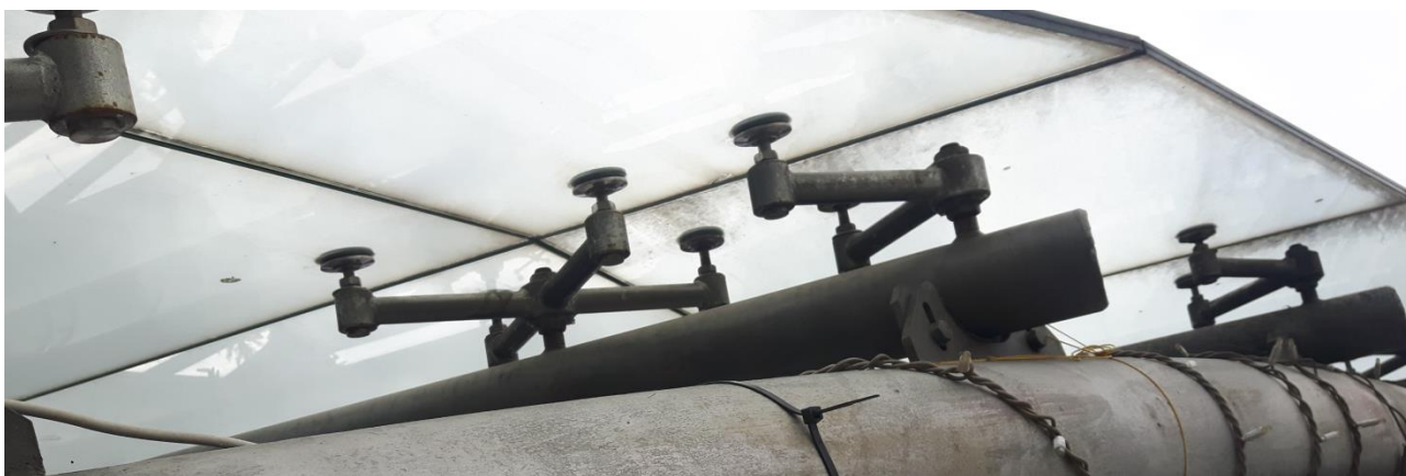
Fot. nr 2. Widok krzyżaków i rotuła nad sceną.
