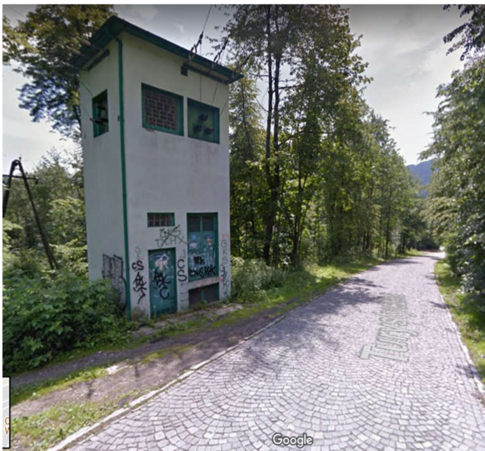
Rysunek 40. Budynek stacji transformatorowej na ul. Turystycznej.
