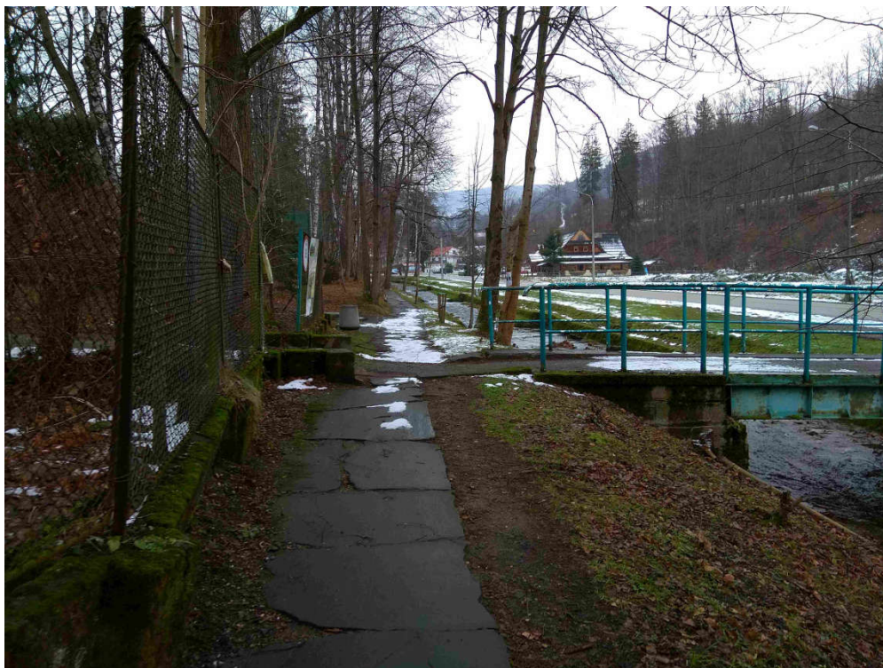
Rysunek 8. Widok na obiekt mostowy nad strumieniem Jaszowiec. Droga dojazdowa do kompleksu Wypoczynkowego Arkadia.
