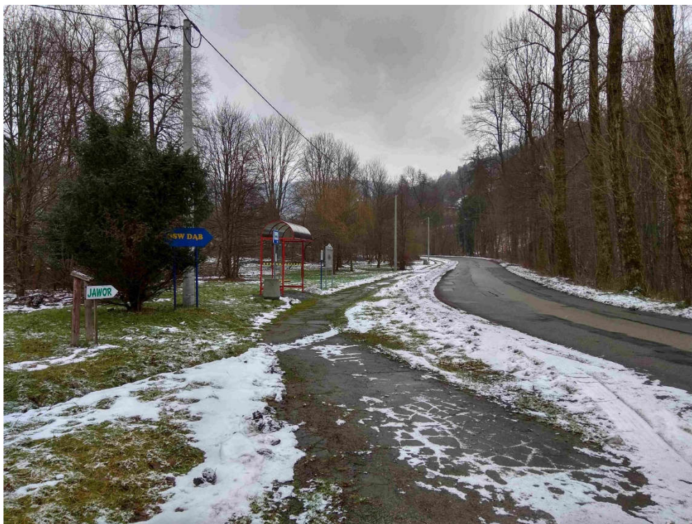
Rysunek 15. Stan techniczny chodnika wzdłuż ul. Wczasowej na wysokości Domu Nauczyciela wraz z widokiem na przystanek autobusowy.
