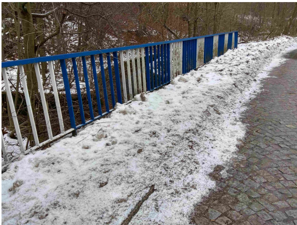
Rysunek 17. Widok chodnika na obiekcie mostowym na ul. Wczasowej przy zaporze przeciwrumoszowej nr 2.
