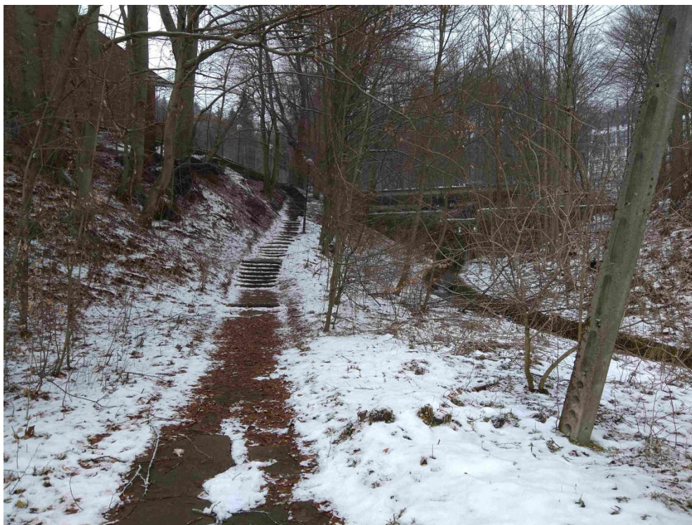
Rysunek 29. Stan techniczny ciągu pieszego przy zaporze przeciwrumszowej nr 2.
