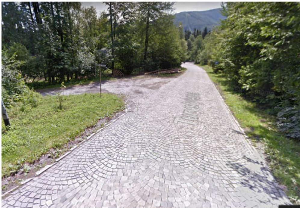
Rysunek 41. Wlot na ślełą uliczkę na ul. Turystycznej powyżej stacji transformatorowej.
