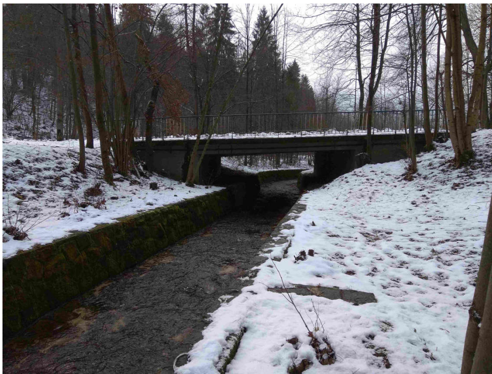
Rysunek 27. Widok na obiekt mostowy na ul. Wczasowej przy zaporze przeciwrumszowej nr 1.
