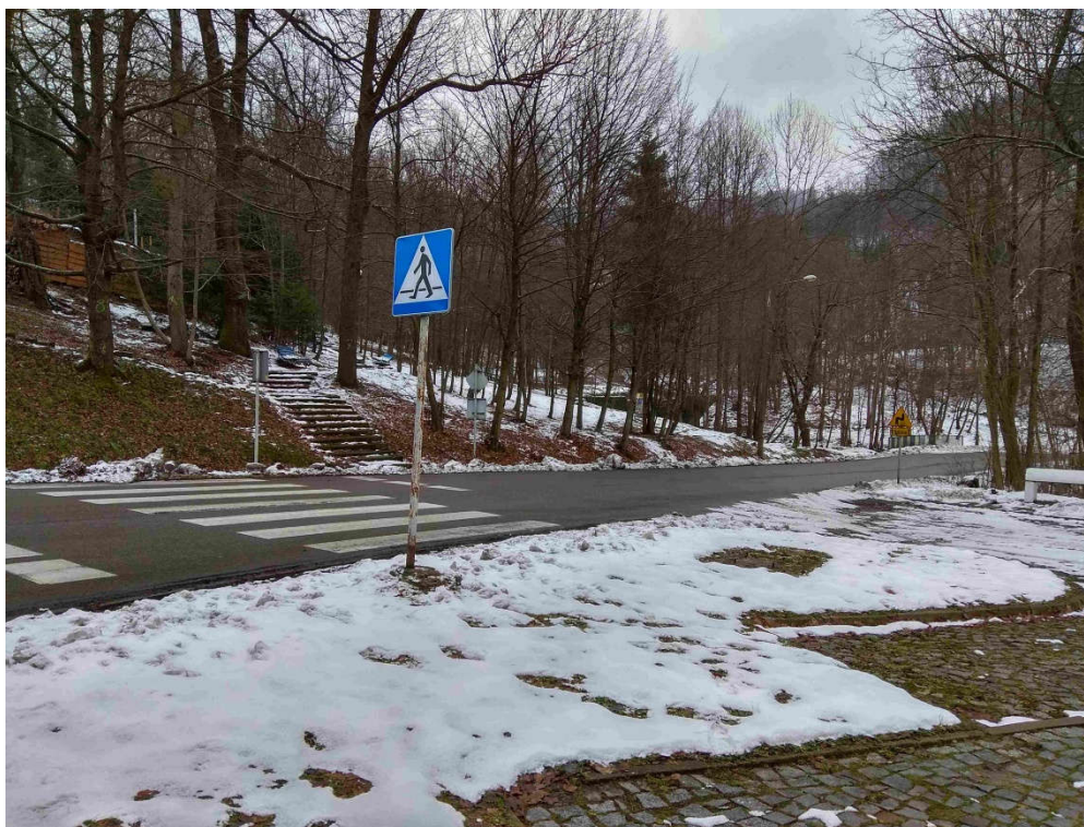
Rysunek 20. Przejście dla pieszych na ul. Wczasowej przy zaporze przeciwrumszowej nr 2.
