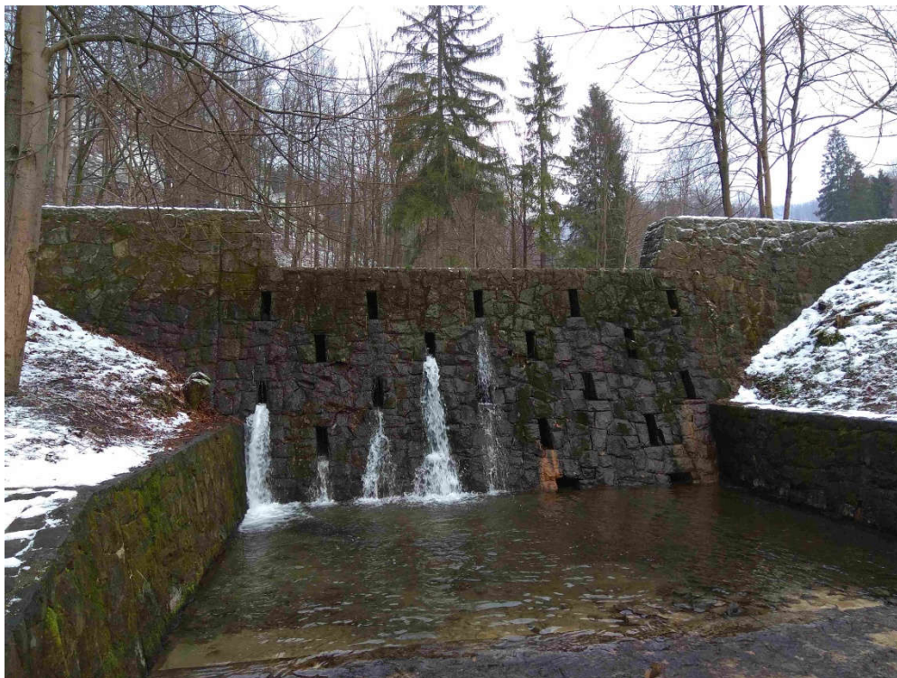
Rysunek 21. Widok z przodu na zapórę przeciwrumszową nr 1 na strumieniu Jaszowiec.
