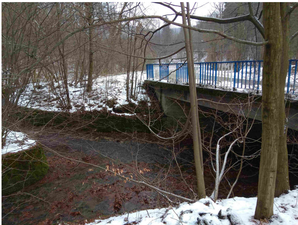
Rysunek 30. Widok na obiekt mostowy na ul. Wczasowej przy zaporze przeciwrumszowej nr 2.
