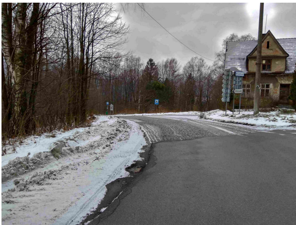
Rysunek 39. Widok na ul. Turystyczną w miejscu zmiany nawierzchni.
