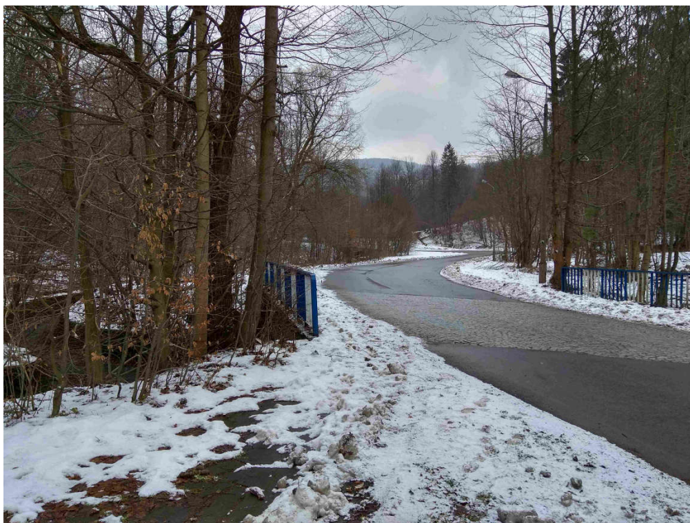
Rysunek 18. Ulica Wczasowa na wysokości obiektu mostowego przy zaporze przeciwrumoszowej nr 2.
