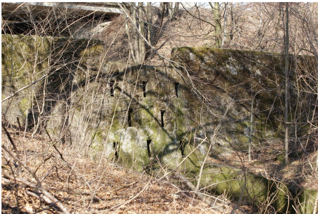
Zdjęcie 7 Zapora przeciwrumowiskowa (zapora nr 2) na dopływie potoku Jaszowiec
