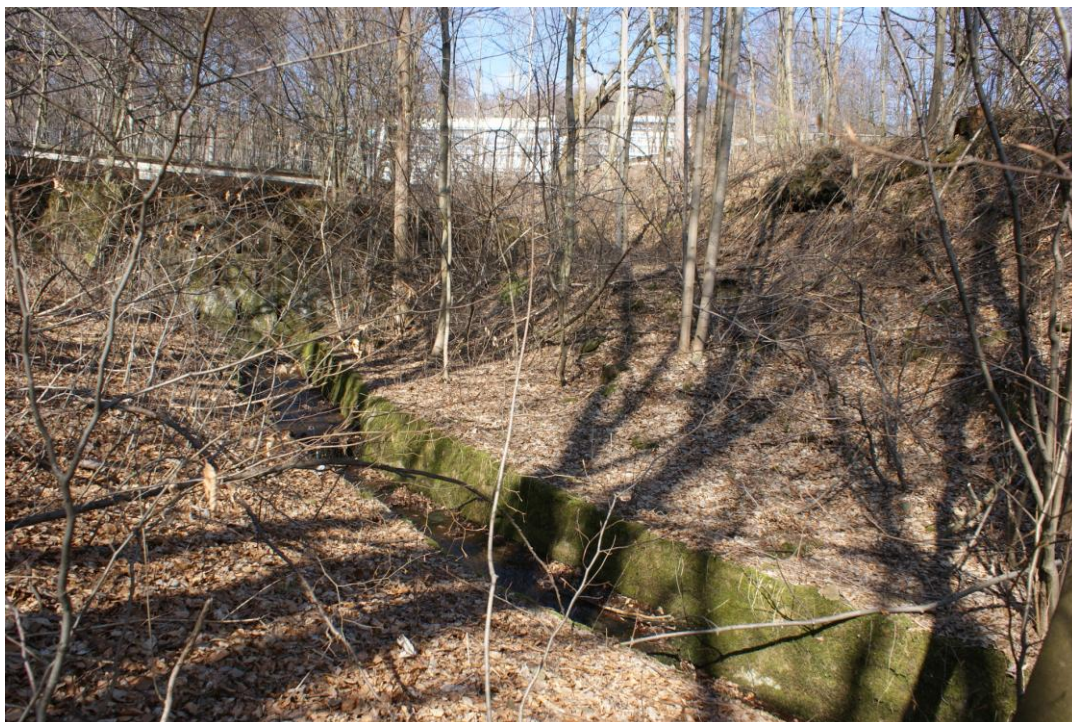
Zdjęcie 5 Uregulowane koryto dopływu potoku Jaszowiec - poniżej małej zapory przeciwrumowskiej (zaporę nr 2)
