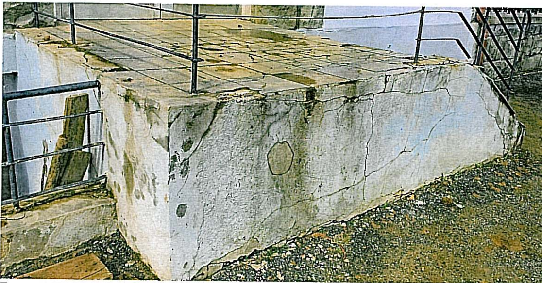
Fot. nr 4. Uszkodzone tynki schodów.
