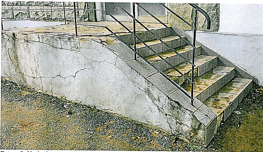
Fot. nr 3. Uszkodzone tynki schodów.
