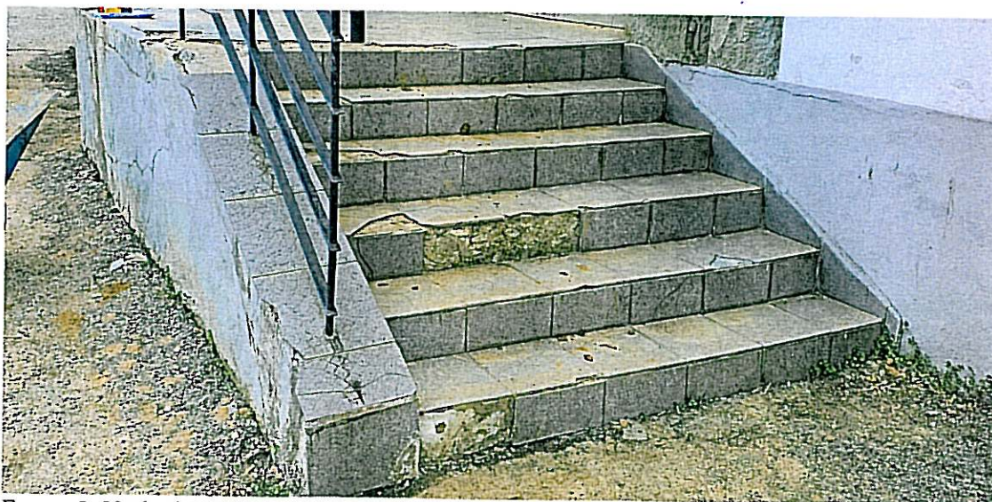
Fot. nr 2. Uszkodzone płytki posadzkowe schodów górnych.
